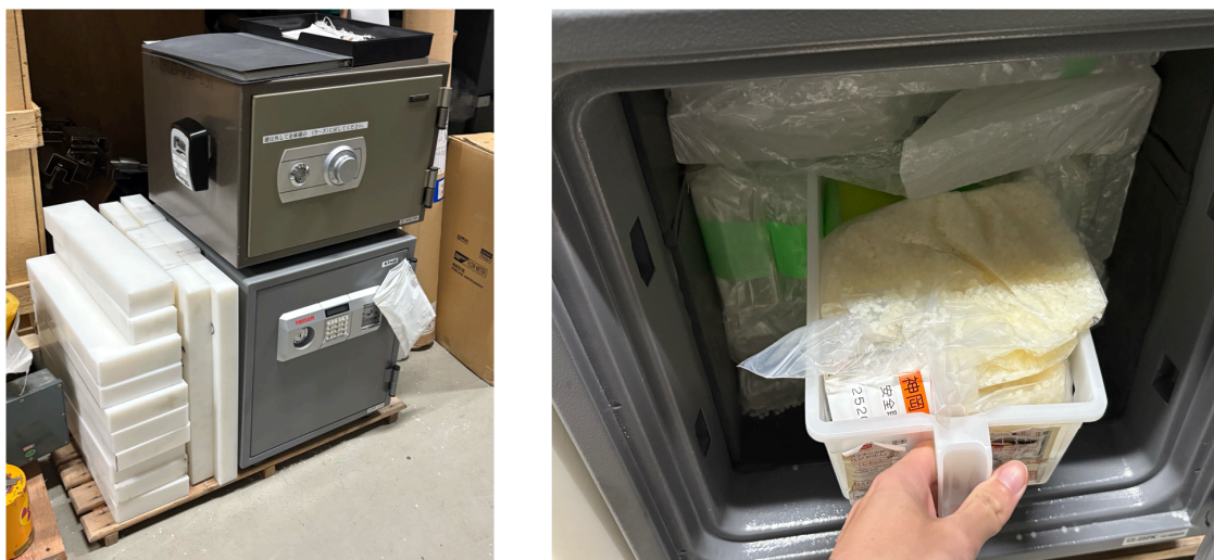
図 35: 地下線源金庫の外観と金庫内の保管状況 （左）線源金庫の外観と遮蔽体の設置状況 （右）金庫内の保管状況 線源はポリエチレン等で覆われた状態で保管されている。
